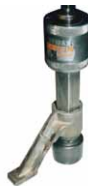
Voimanmuuntimen katkenneen tukijalan korjaus.
